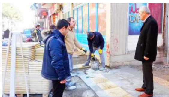
Osmancık Belediyesi'nin kaldırım yenileme çalışmaları Yazı Mahallesi'nde devam ediyor.
